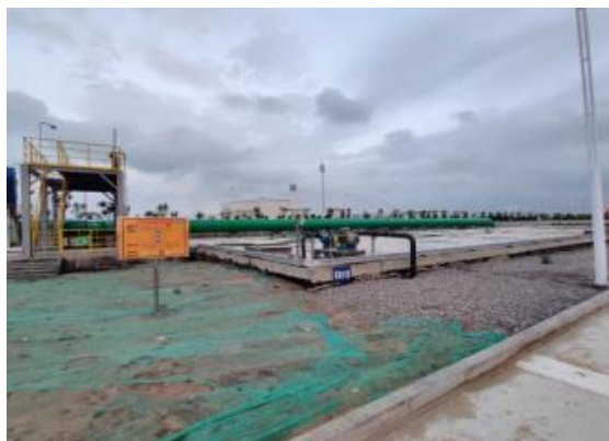
危废暂存库导排
